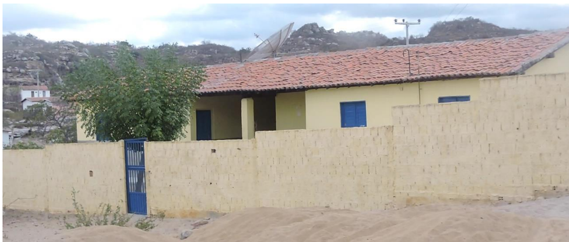
Foto 20: Primeiro prédio da escola no Sítio Velho.
